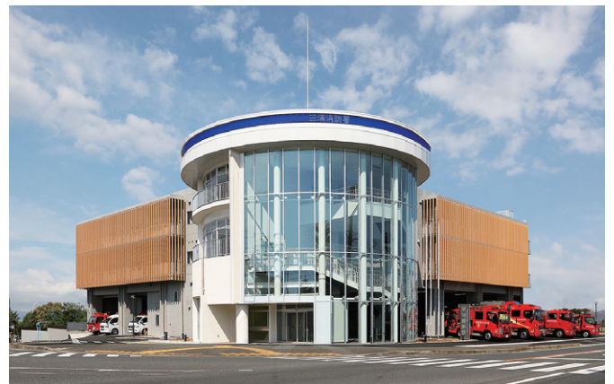
国・県の財政支援を受けて建設した三浦消防署
